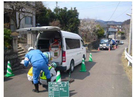
東日本大震災時の管きょ二次調査の様子
